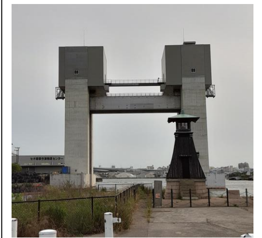
今津港水門(建設中)
