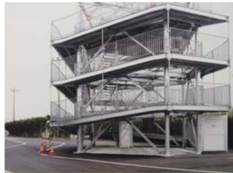
震災後設置された津波避難タワー 飯岡地区5基
